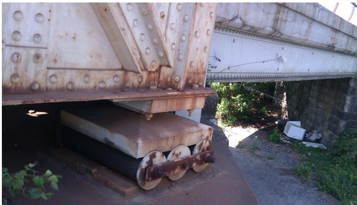
Obr. 6-3 Detail uloženia
