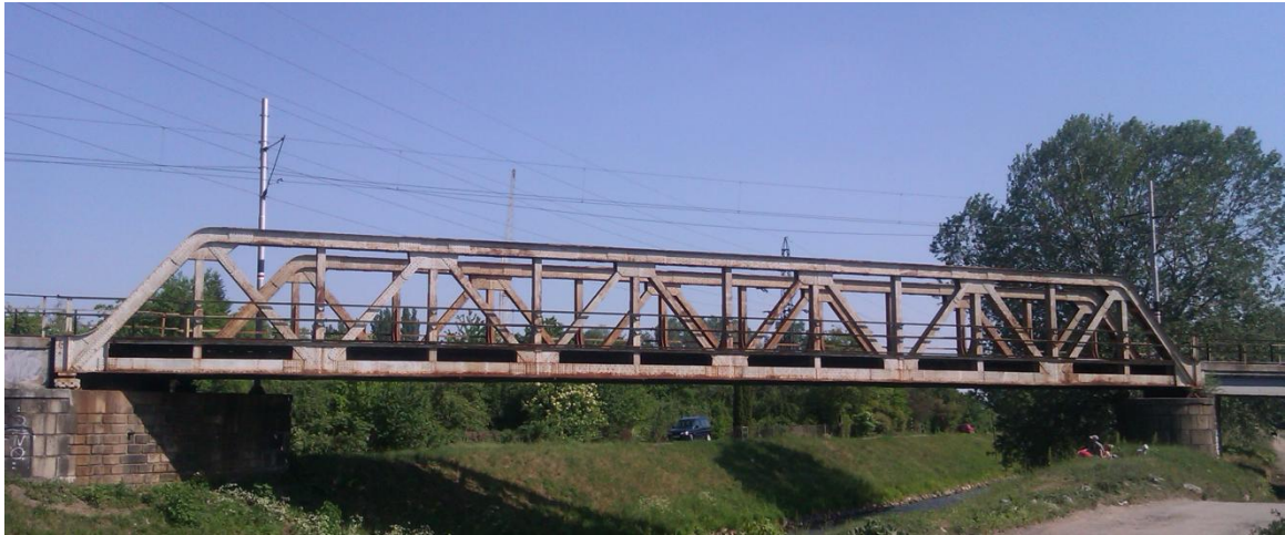
Obr. 1-1 Riešený železničný most
