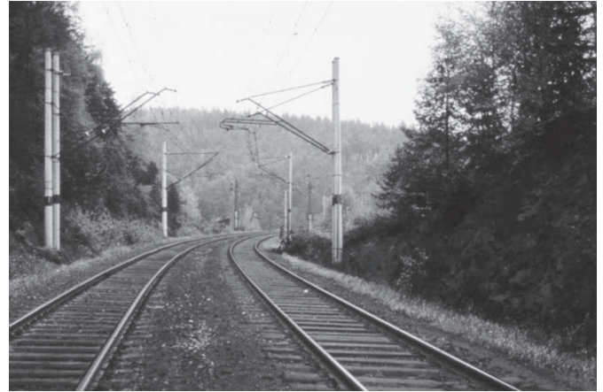
Obr. 6 Příjezd ze zářezu od Níhova na předemtný viadukt – směr jízdy nákladního vlaku a následně solo lokomotivy ELv 900 (snímek z roku 1971).
