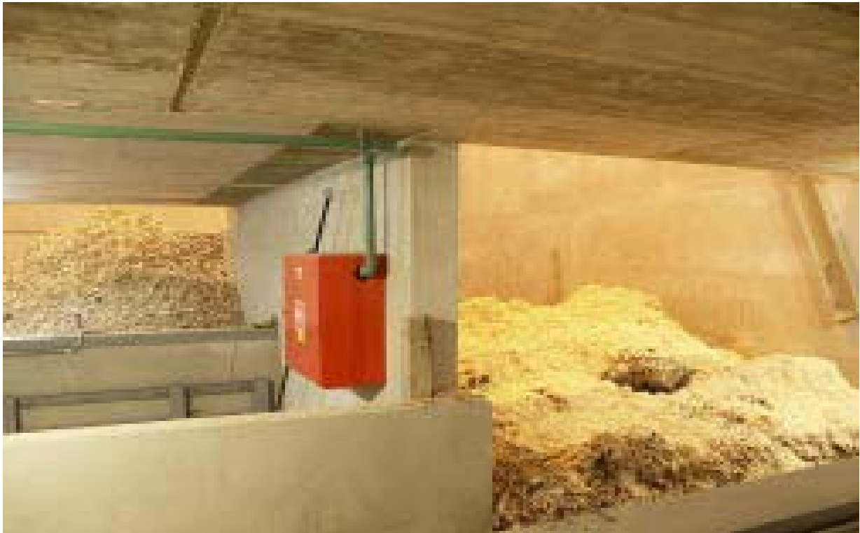
Obrázek č. 5: Podavač paliva [16]
