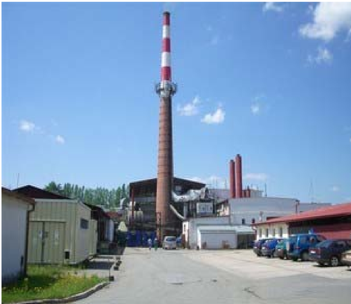
Obrázek č. 7: Kogenerační jednotka Pelhřimov [17]
