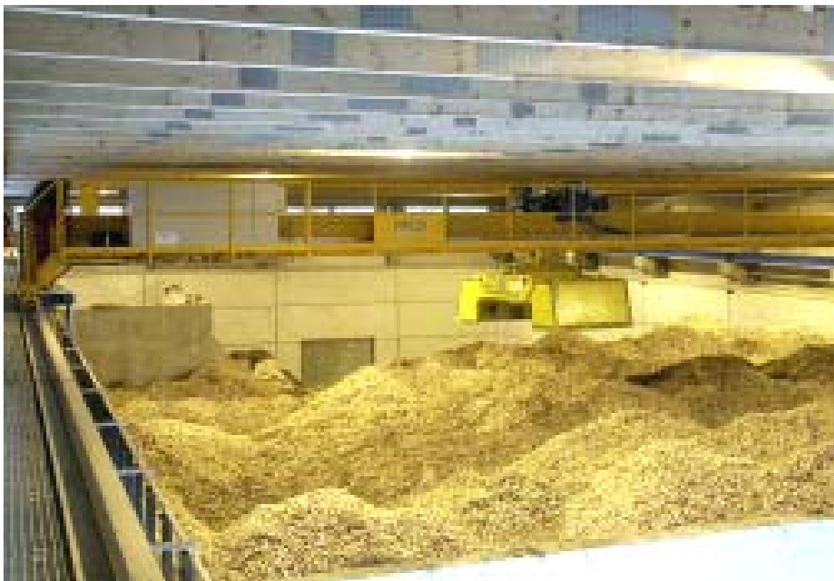
Obrázek č. 4: Sklad – vnitřní pohled s drapákem [16]
