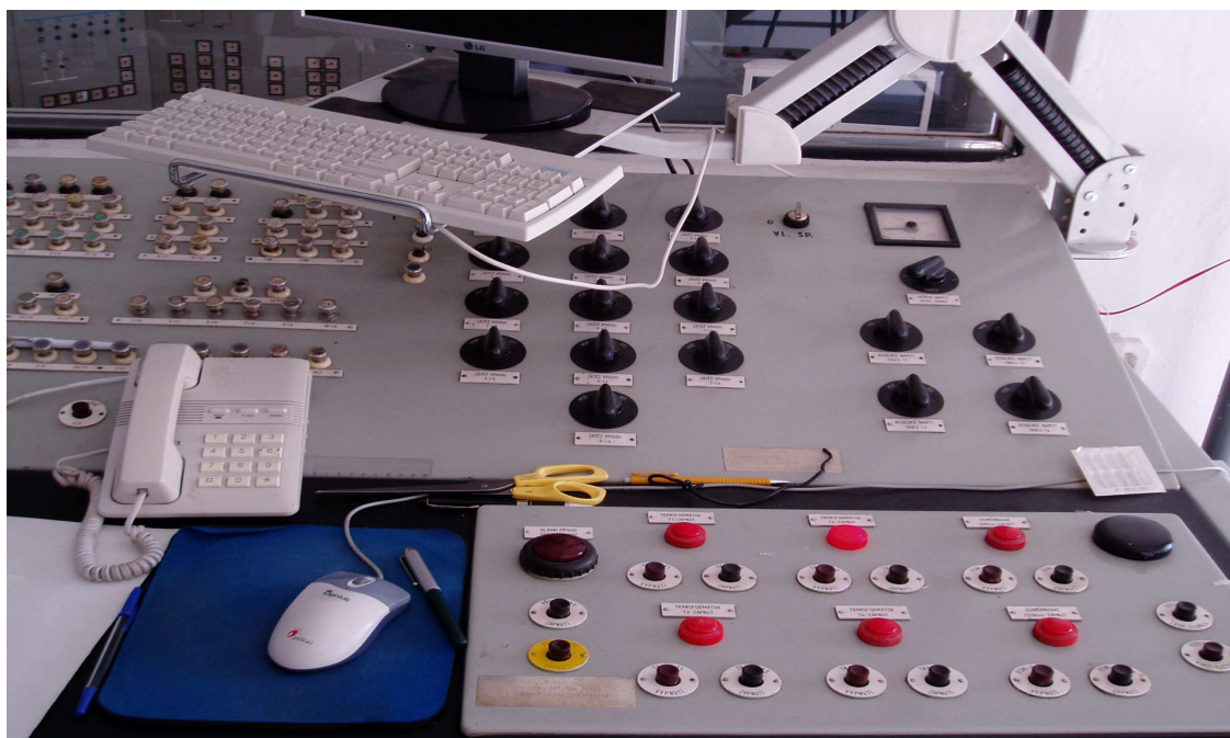
Obrázek č. 3: Manipulační pult školitele v řídicím velínu
