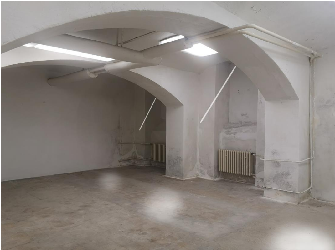
↑ Návrh I - 3 skleněné tyče (1500 × 25 mm) umístěny do nik, propouští světlo do uzavřeného prostoru
