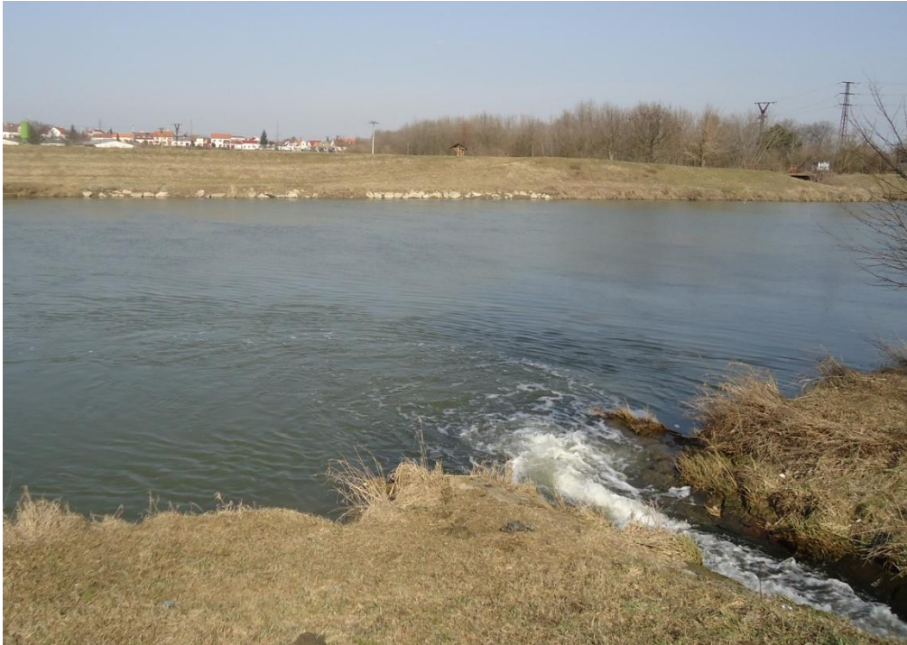
Obr. 18.: Lokalita odběru Uherské Hradiště – výpusť ČOV.
