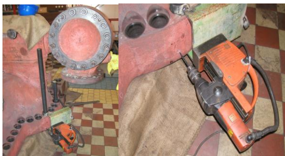
Obr. 5.7 Vrtání bloku parní turbíny
