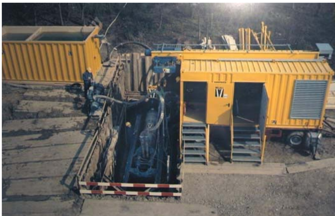
Obr. 3.16 Příklad použití zařízení RVS od firmy Soltau
