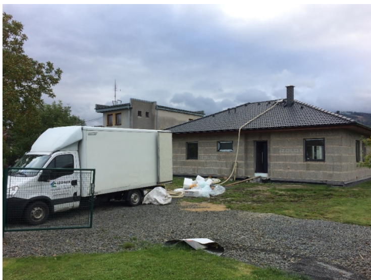
Obrázek 1: Zakázka – instalace foukací hadice do konstrukce střechy
