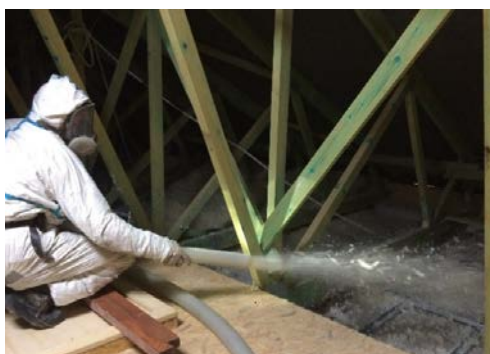
Obrázek 2: Realizace foukané izolace
