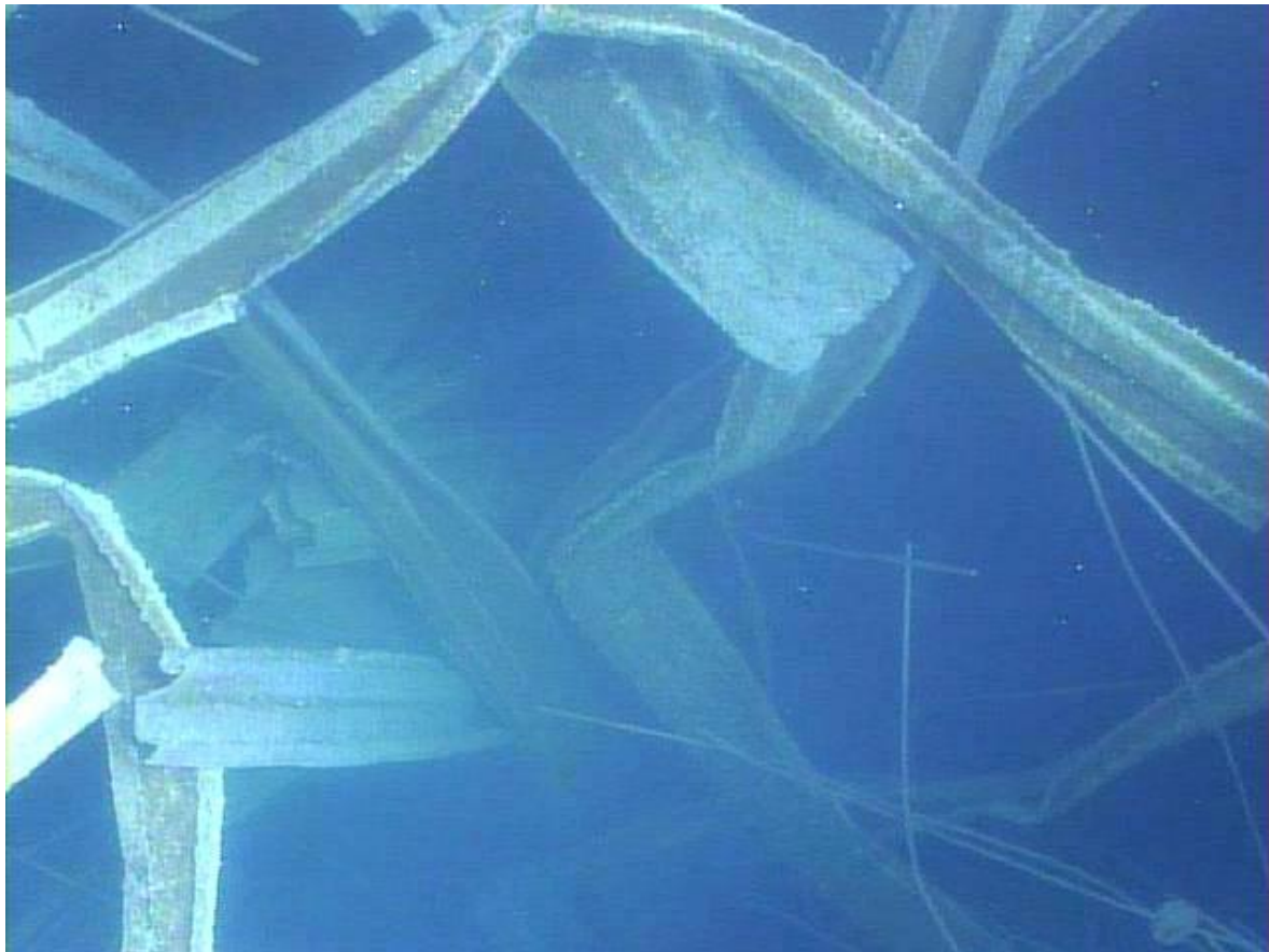
Obrázek 4.1: Trosky v bazénu vyhořelého paliva na třetím bloku [31]
