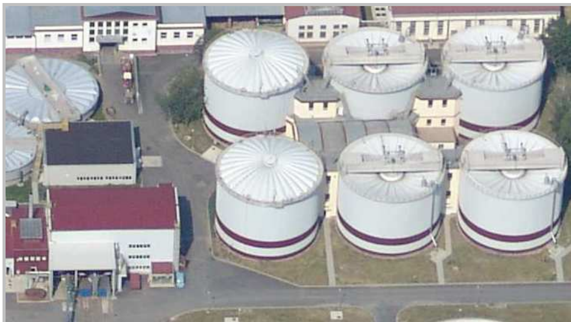
Obr. 4.2 Vyhnívací nádrže ČOV Brno - Modřice [6]
