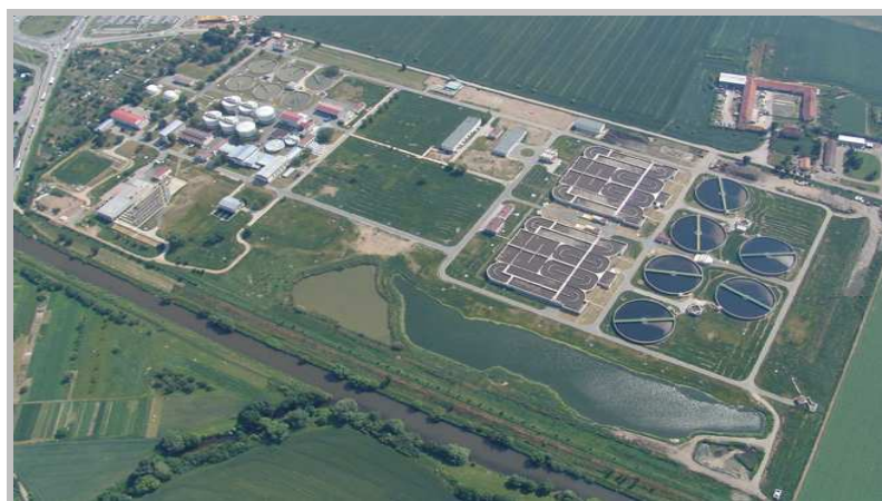
Obr. 2.1 ČOV Brno – Modřice – celkový pohled [6]
