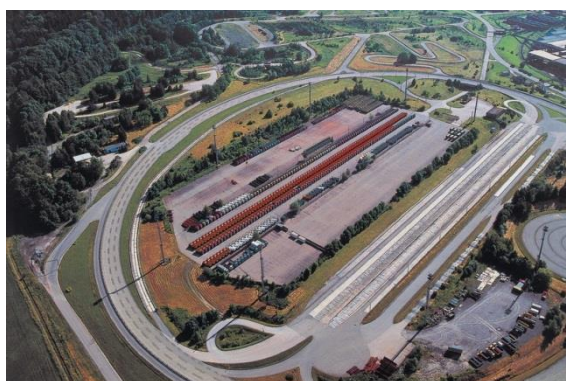
Obr. 2.6 Areál TATRA Kopřivnice [19]
