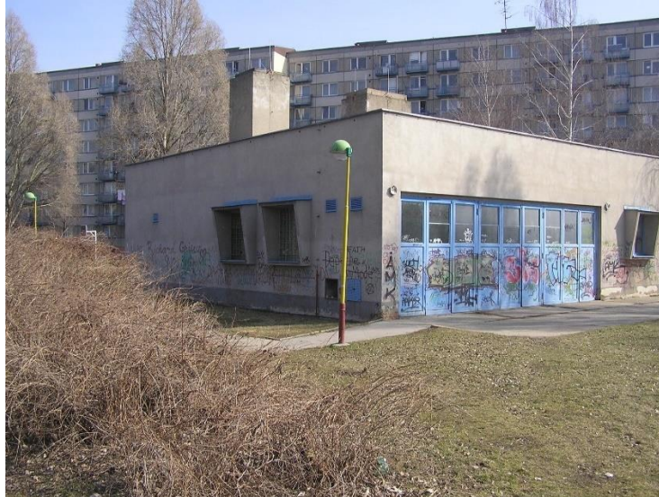
Obr. č. 4: Bývalá kotelna centrálního tepelného zdroje /Vlastní zdroj/
