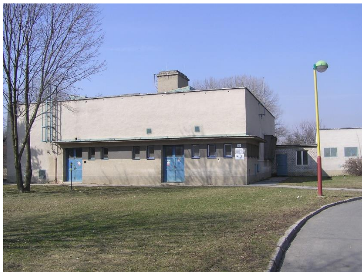
Obr. č. 5: Bývalá kotelna na pozemku /Vlastní zdroj/
