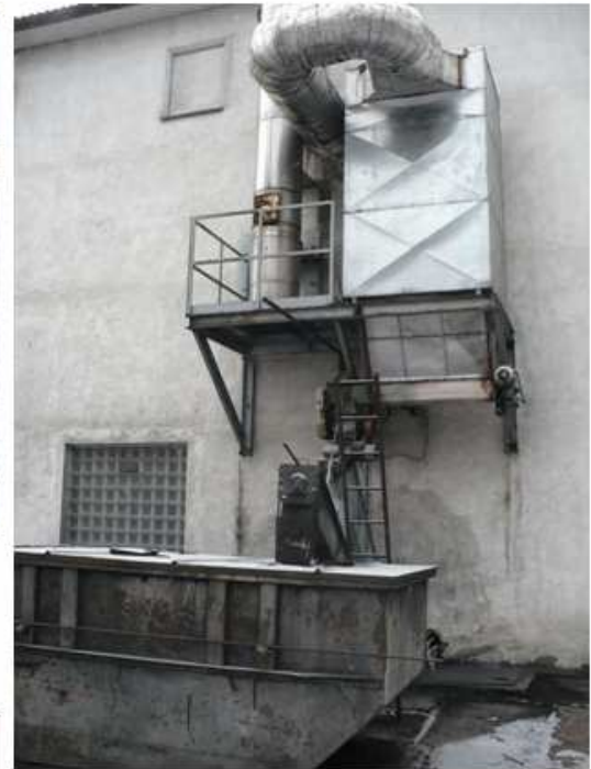
Obr. 10 nahoře. Odvod popela do připraveného kontejneru. Výše komín s multicyklónovým odlučovačem.
