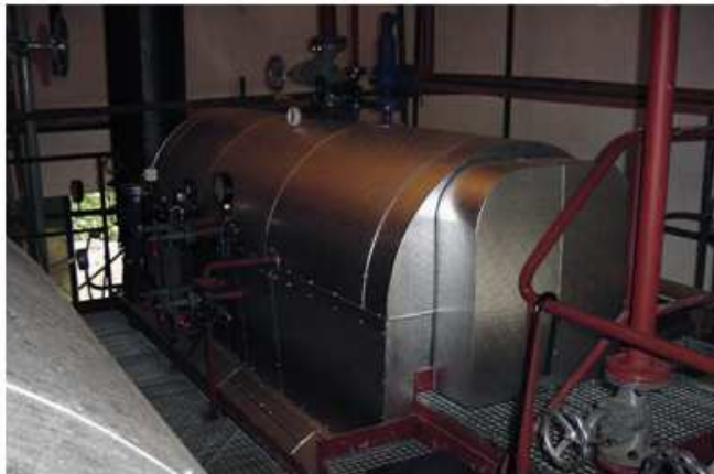
Obr. 9 Spalovací komora v dvoudenní odstávce před čištěním od usazených křemičitanů.
