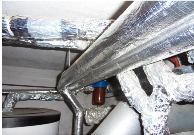
Obr. 2.7 Jednotlivé rozvody vody a teplonosnej kvapaliny
