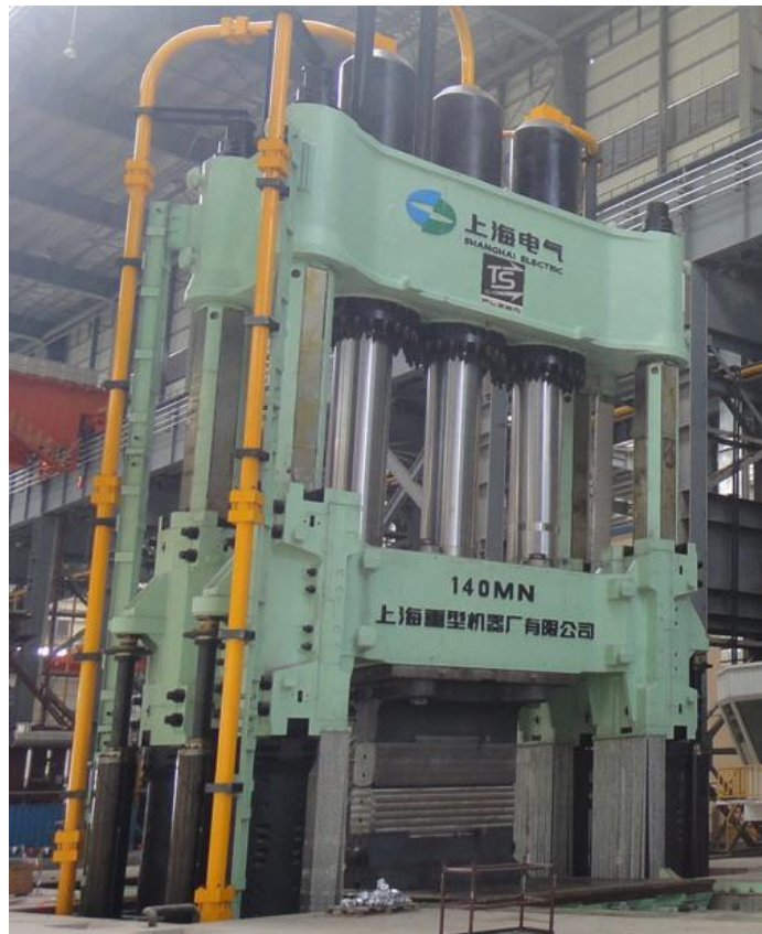
Obr. 27 Přívod hydraulického potrubí k lisu [19]
