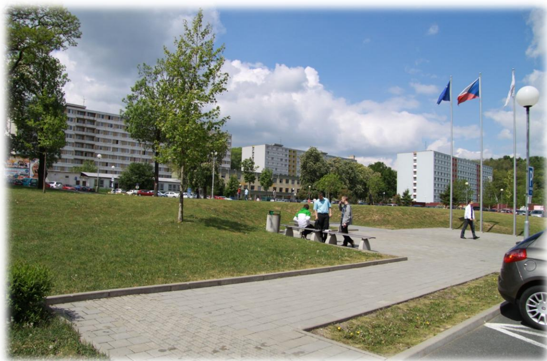
Obrázek 3.1: Koleje pod Palackého vrchem
