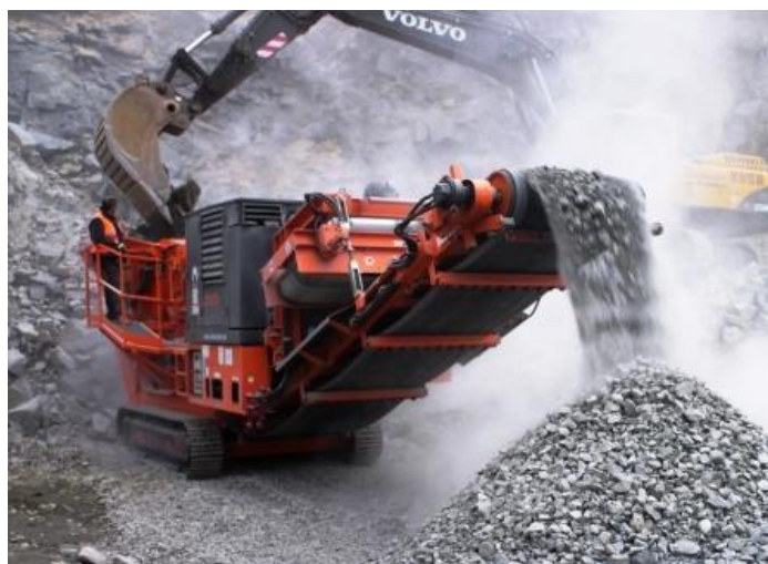
Obr. 2 Drcená suť, převzato z [5] (na obrázku drtič kamene a stavebního odpadu)
