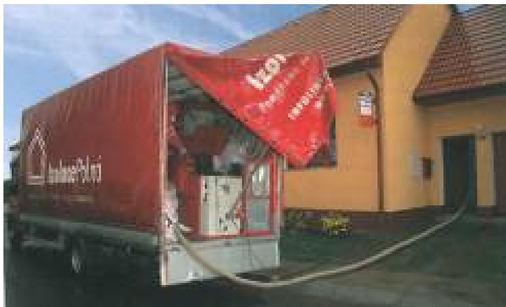
Obrázek 16: Ukázka foukacího stroje
