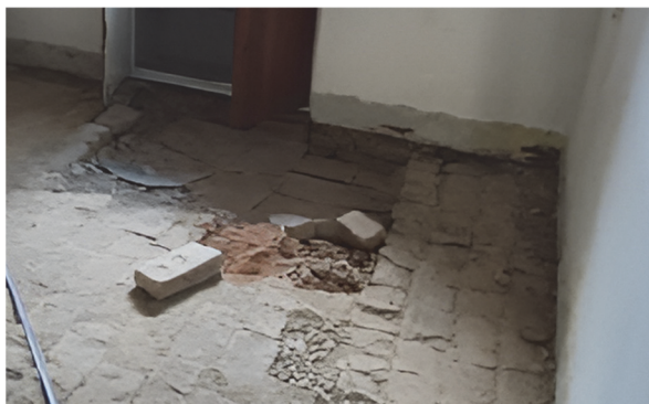
Obrázek 4 – Hmotná vrstva z pálených cihel na záklopu dřevěného trámového stropu obytné budovy ze začátku 20. století, jedná se o stropní konstrukci mezi byty, nikoli o půdní prostor (foto: Ing. Marek Fric)
