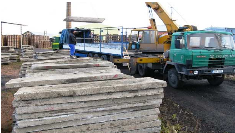
Obr. 3.4 Stavba staveništní komunikace
