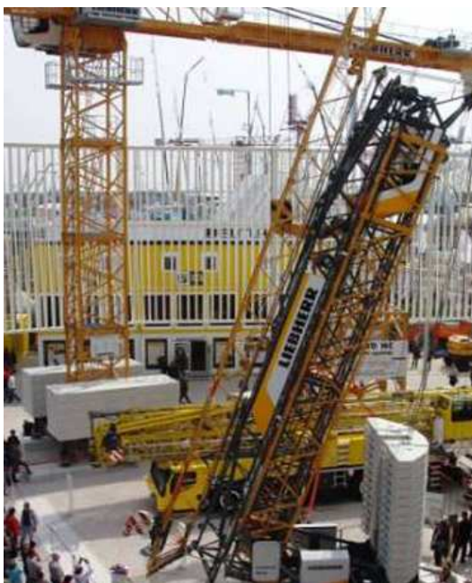
Obr. 3.7 Jeřáb Liebherr 81K
