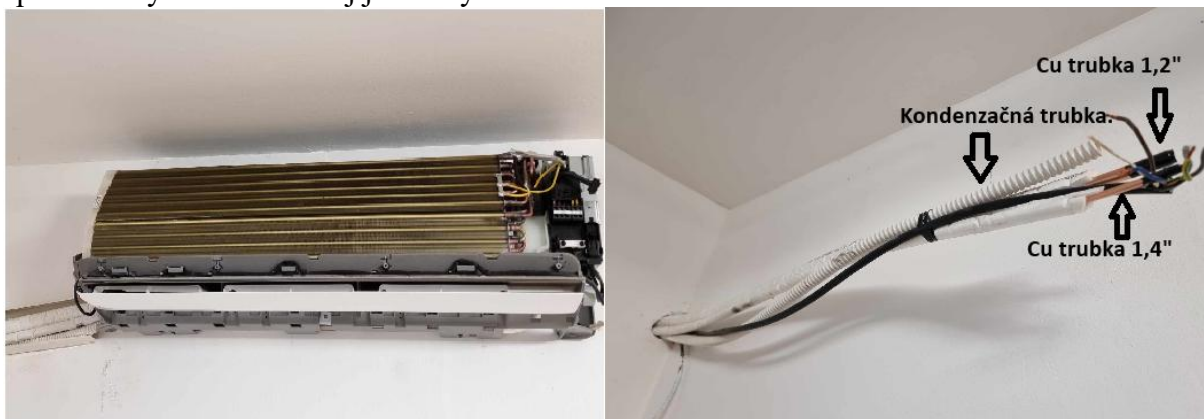
Obr. 10. Príprava kabeláže a uchytenie vnútornej jednotky na stenu
