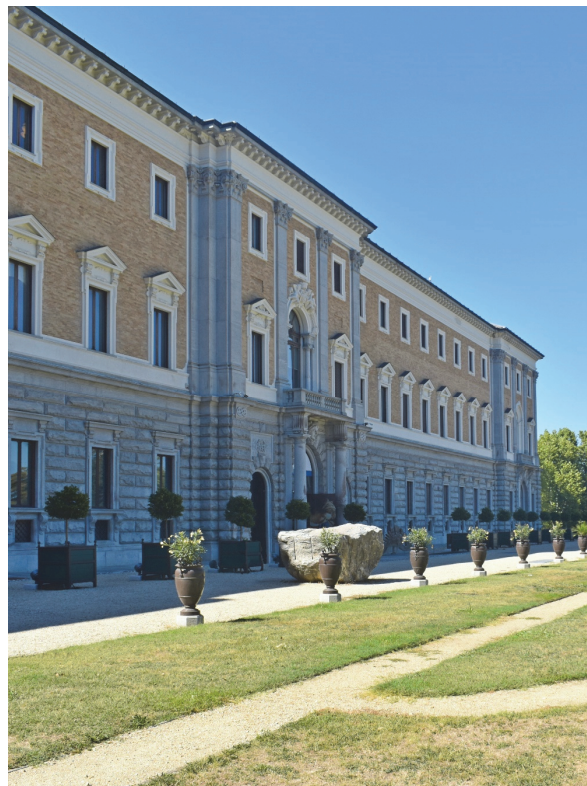
Obrázek 6 – Jedno z průčelí Palazzo Reale v Turíně (zdroj: fotoarchiv autora)
