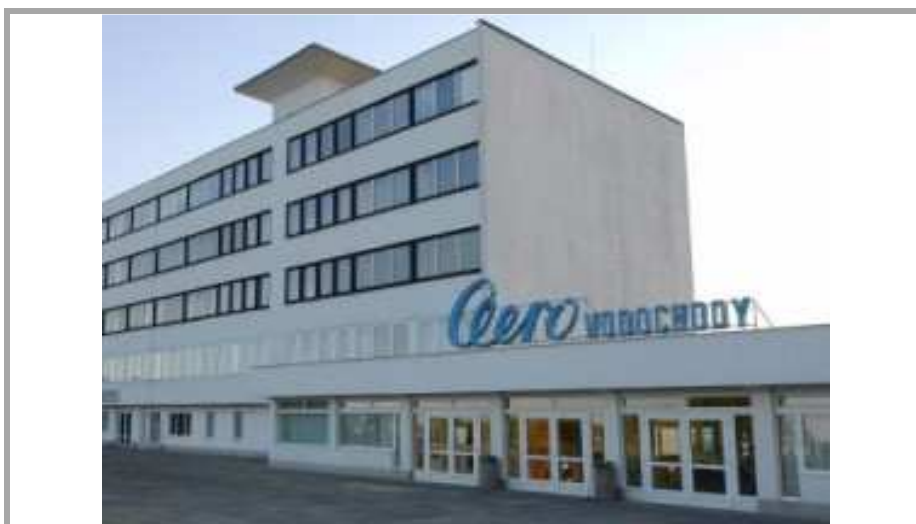
Obr. 5: Hlavní vchod do podniku Aero Vodochody [7]
