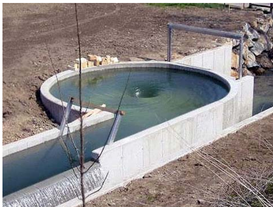
Obr. 5.8 Gravitační vírová vodní elektrárna
