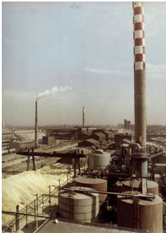
OBR. Č. 7: AREÁL PODNIKU V ROCE 1975
