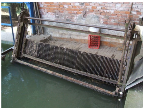
Obr. 25 Řetězový hrabací stroj
