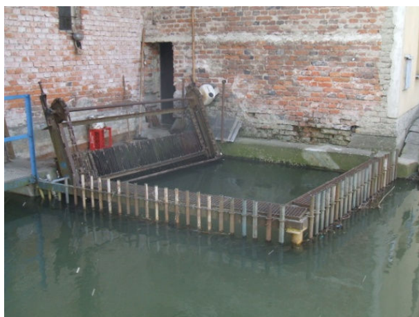
Obr. 24 Uspořádání česlí
