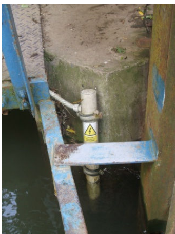
Obr. 22 Tlakové čidlo hladinové regulace
