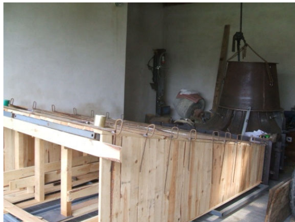
Obr. 33 Bednění savky
