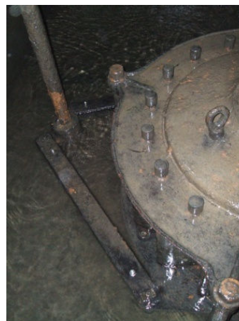
Obr. 7 Regulační srdce s táhly, regulační tyč
