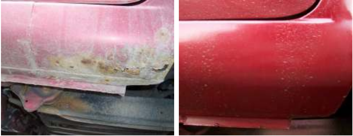
Obr.4 Oprava skorodovaného prahu osobného automobilu
