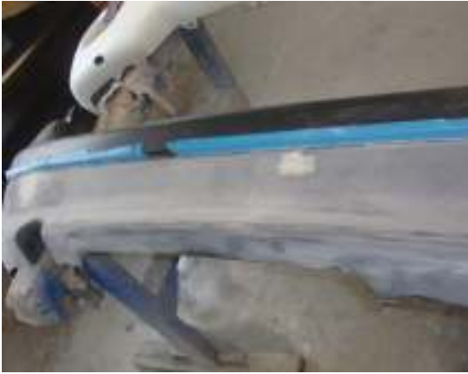
Obr. 5: Opracovaný materiál, zbavený všetkých nečistôt a pripravený na základnú farbu
