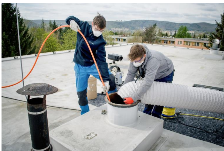
Obrázok 3-2 Čistenie vzduchového potrubia zo strechy paneláka. [37]
