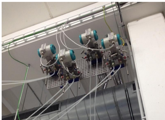
Obr. 10: Převodníky diferenciálního tlaku Prandtlovy trubice
