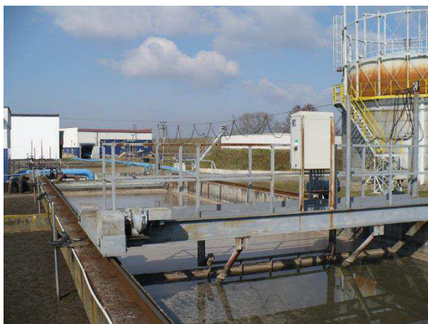
Obr. 12 Obdélníková usazovací nádrž před rekonstrukcí
