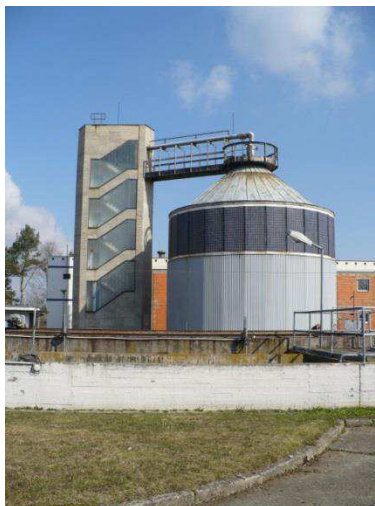
Obr. 15 Vyhnivací nádrž před rekonstrukcí
