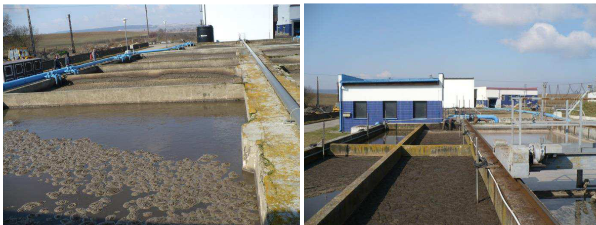
Obr. 13 Aktivační nádrže (vlevo) a nádrže regenerace kalu (vpravo) před rekonstrukcí
