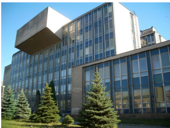
Obr.d Budova Letecké fakulty Technické university v Košicích s železobetonovou konstrukcí (ocelový skelet s kombinovanou výplní skleněných tabulí a železobetonových panelů) [26].
