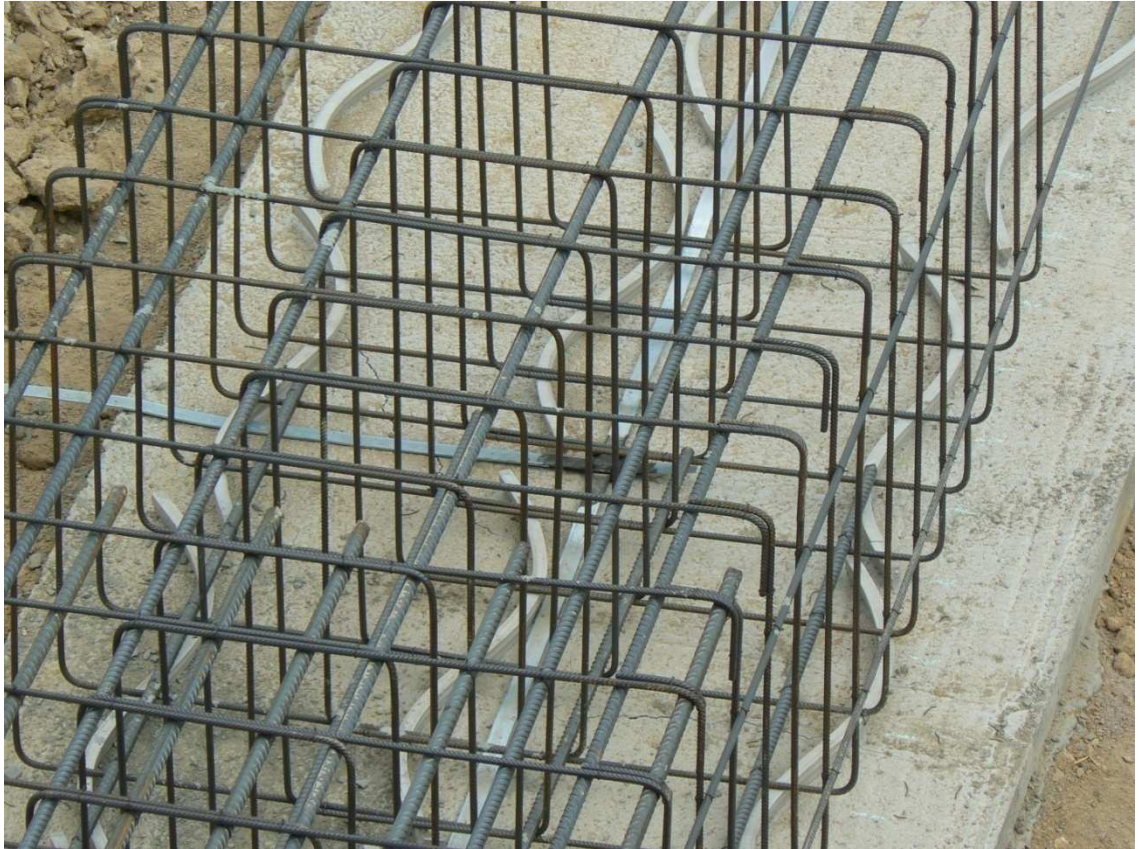
Obr. 5-5: Výstuž základového pásu
