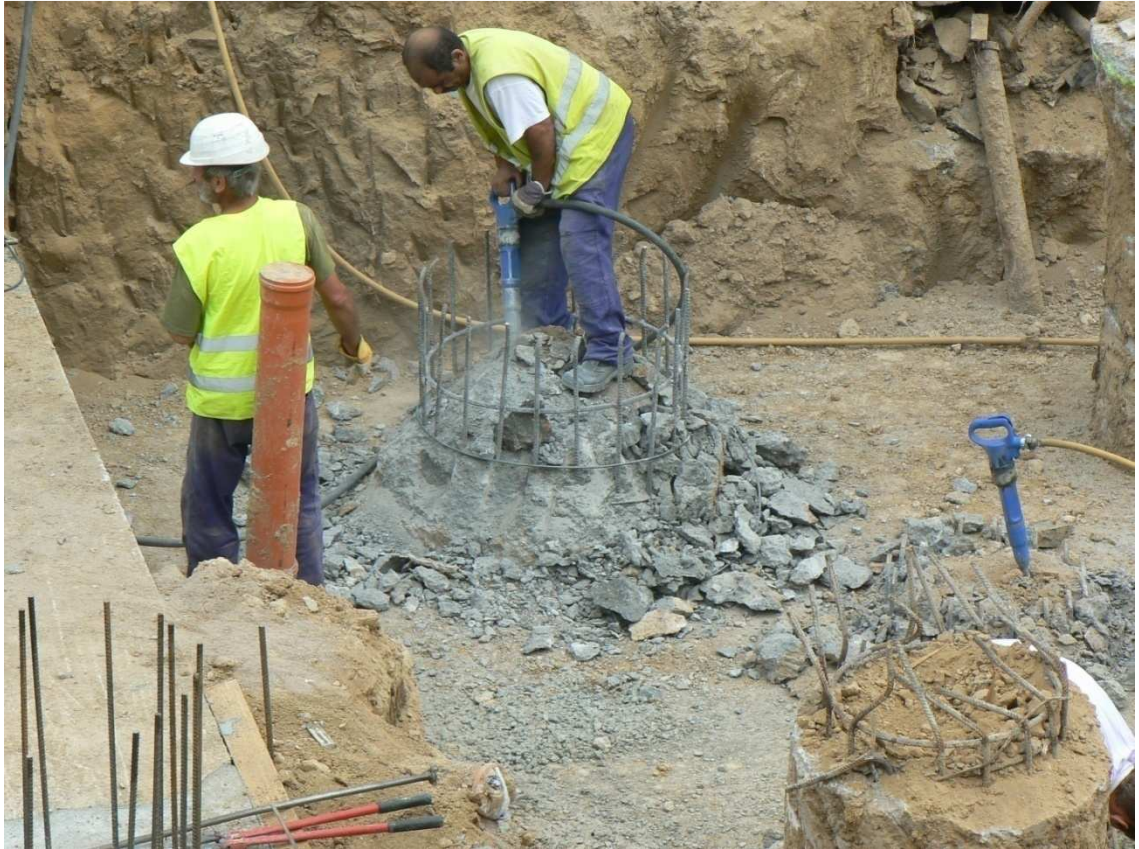
Obr. 5-3: Odbúranie nadbetónávky hlavy pilóty
