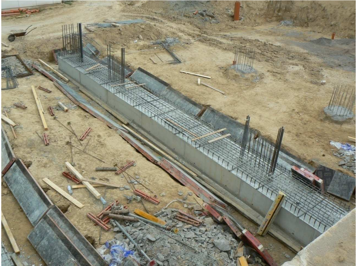
Obr. 5-7: Dokončený základový pás s pilóty
