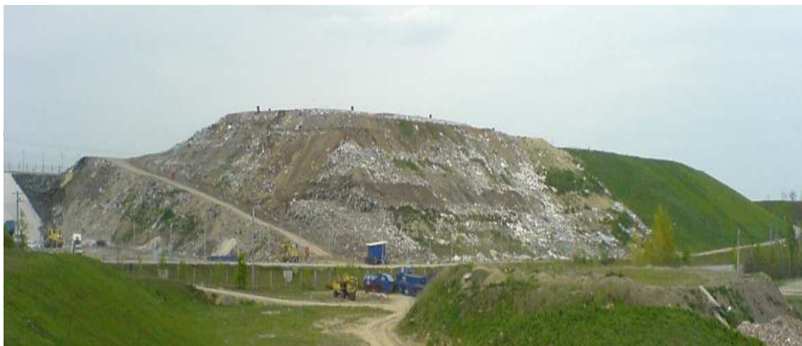
Obr.5 vzhled skládky po částečné rekultivaci
