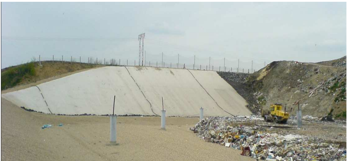
Obr.2 – pohled do spodní části tělesa skládky s těsnicí folií, skládka Žabičce
