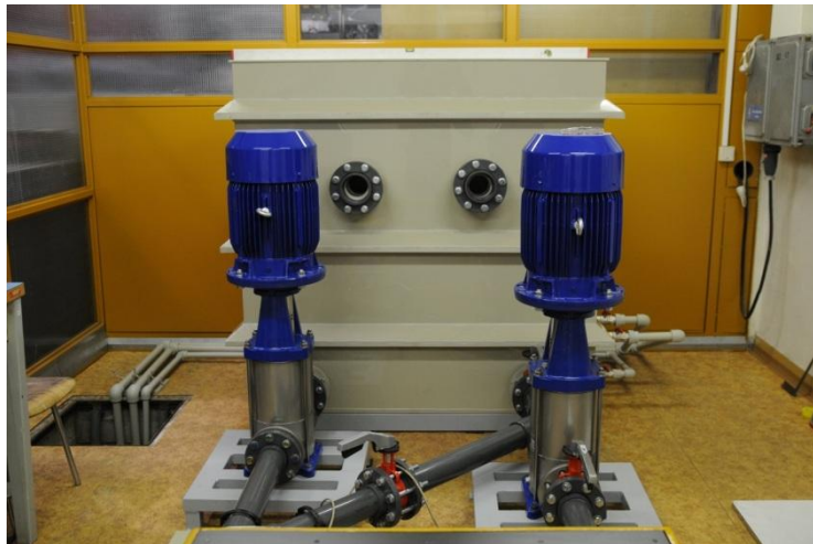
Obrázek 10: Připojení kompresorů k nádrži, zdroj: Ing. Martin Hudec
