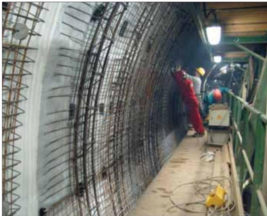
Obr. 3: Montáž výztuže sekundárního ostění [38].
