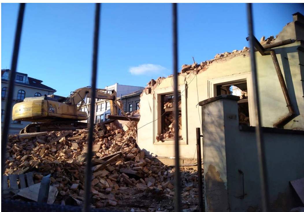
Obr. 12 Fotografie z průběhu realizace demolice
