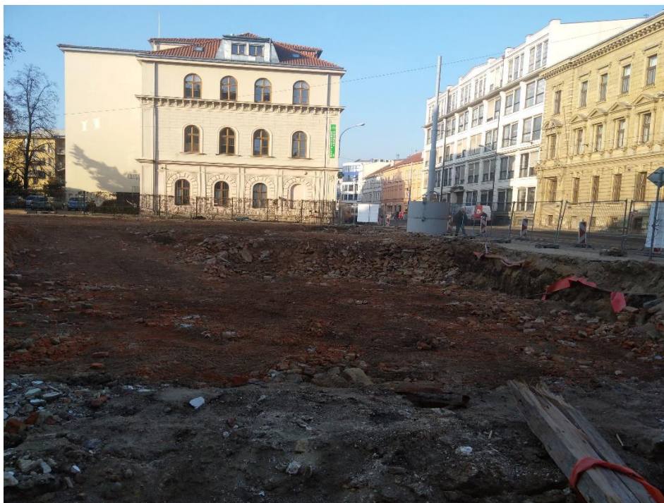
Obr. 13 Fotografie po dokončení demolice
