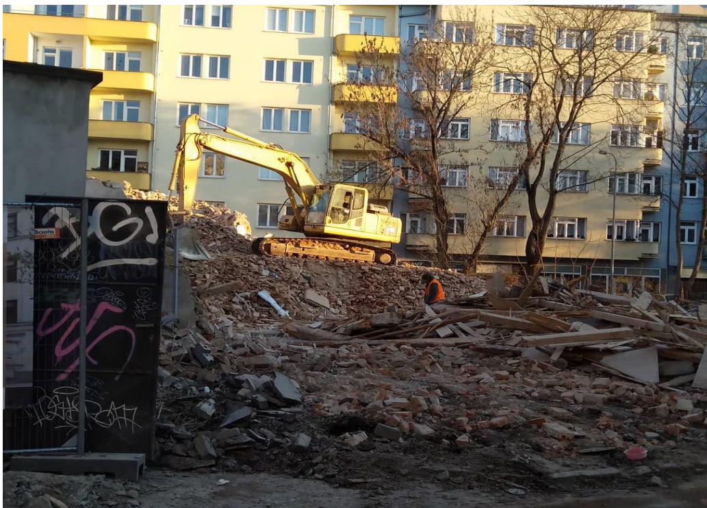
Obr. 11 Fotografie z průběhu bouracích prací
