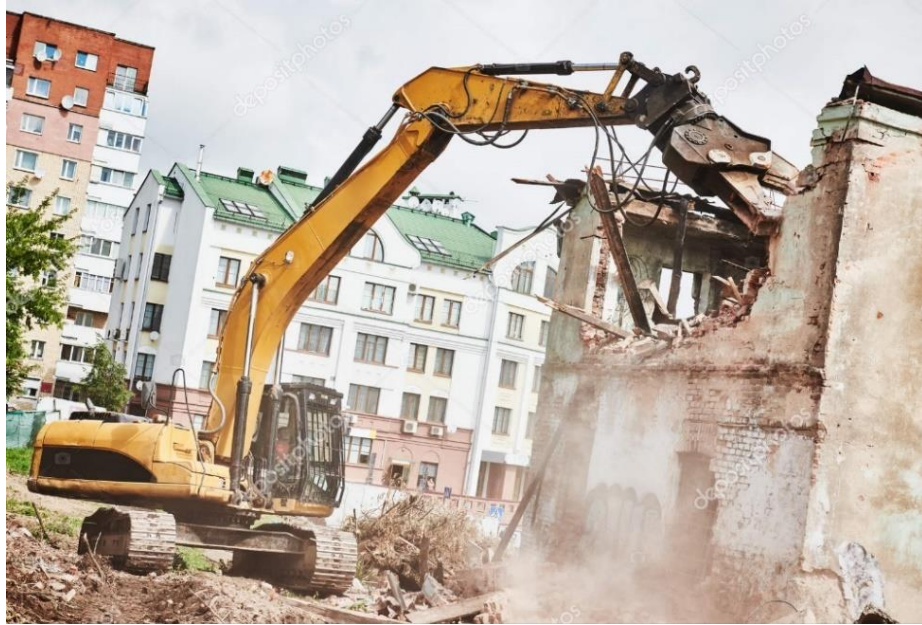
Obr. 3 Použití pásového rypadla s výložníkem při demoličních pracích
