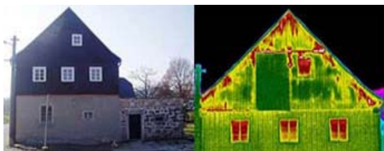
Obr. 5.7 Exteriér horské chaty (tepelné ztráty v podkroví budovy). [14]
