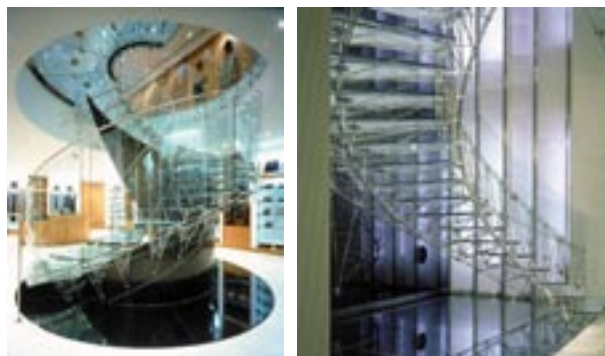
obr.6.o.1. skleněné schodiště od Evy Jiříčné [o35]
