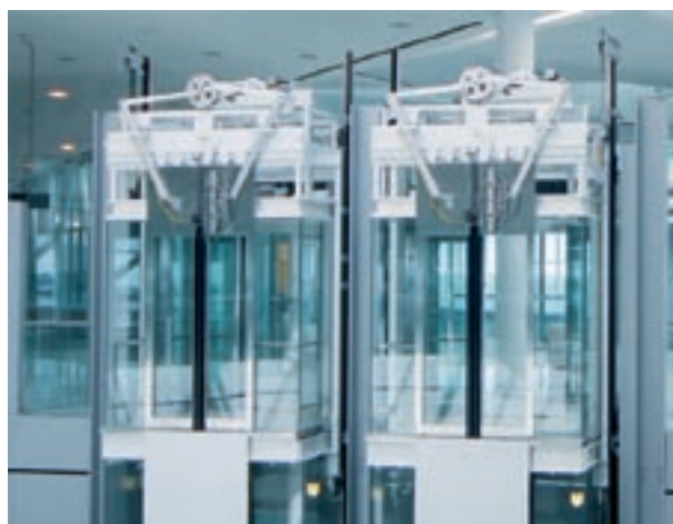
obr.4.4.1. otevírání pomocí mechanických ramen [o33]
