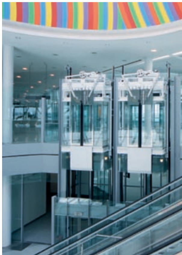
obr.6.o.3. přiznaný mechanismus pohonu dveří [o37]
