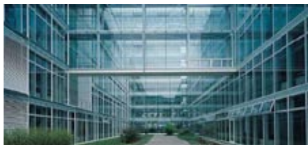
obr.4.1.1. skleněná fasáda [o21]
