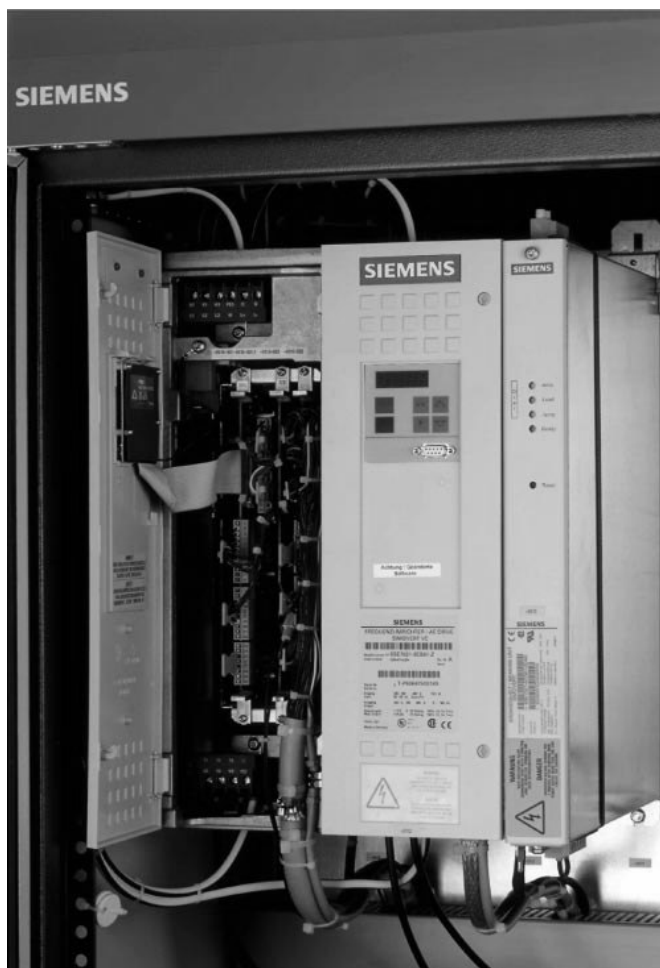
Obr. 4.10: Tranzistorová budící soustava RG3-T4, detail na AVR
