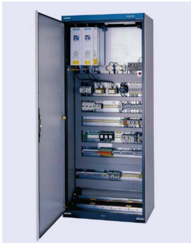
Obr. 4.9: Tranzistorová budící soustava RG3-T4
