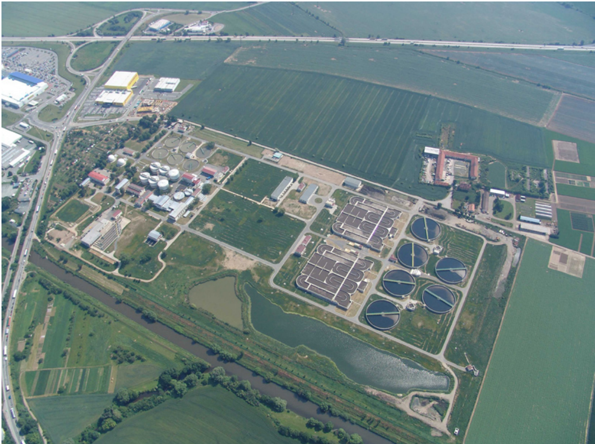
Obr. 58: Čistírna odpadních vod Brno-Modřice [97]
