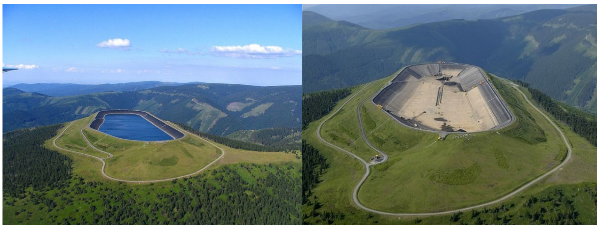
Obr. 3 a 4 – horní nádrž přečerpávací elektrárny Dlouhé Stráně [10] a [11]
