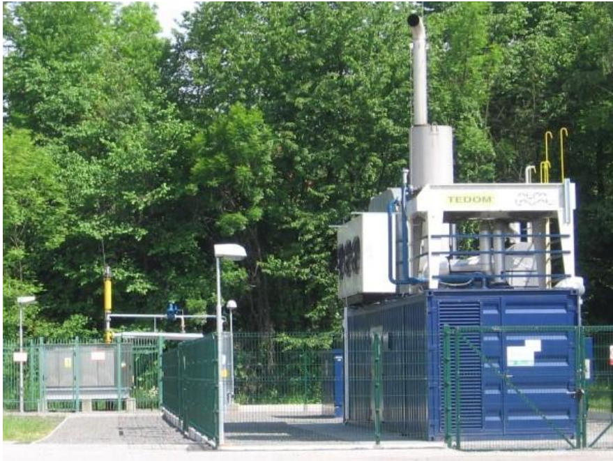
Obrázek 10 Kontejnerová kogenerační jednotka určená ke spalování odpadních plynů [32]
