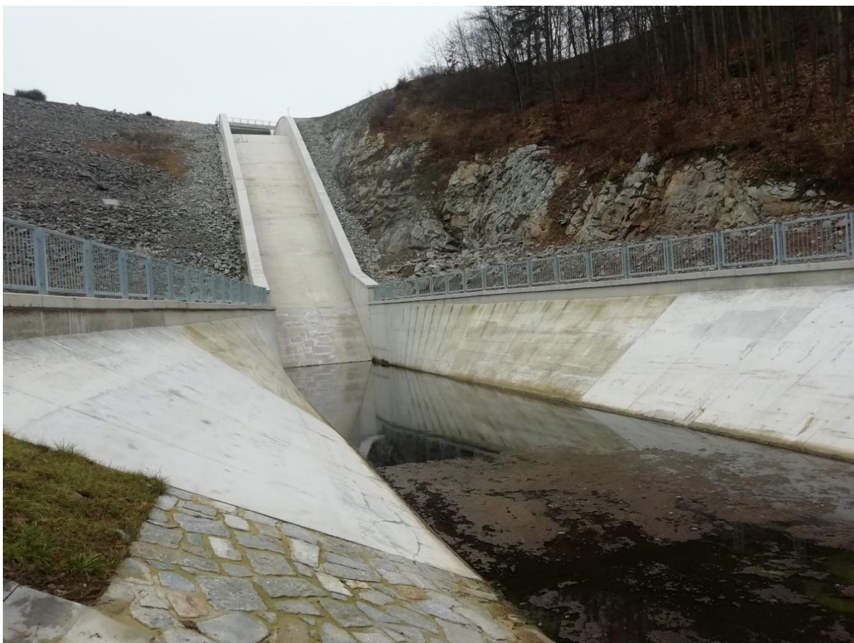
Obrázek 20: Skluz a divergentní vývar bezpečnostního objektu VD Boskovice [24]
