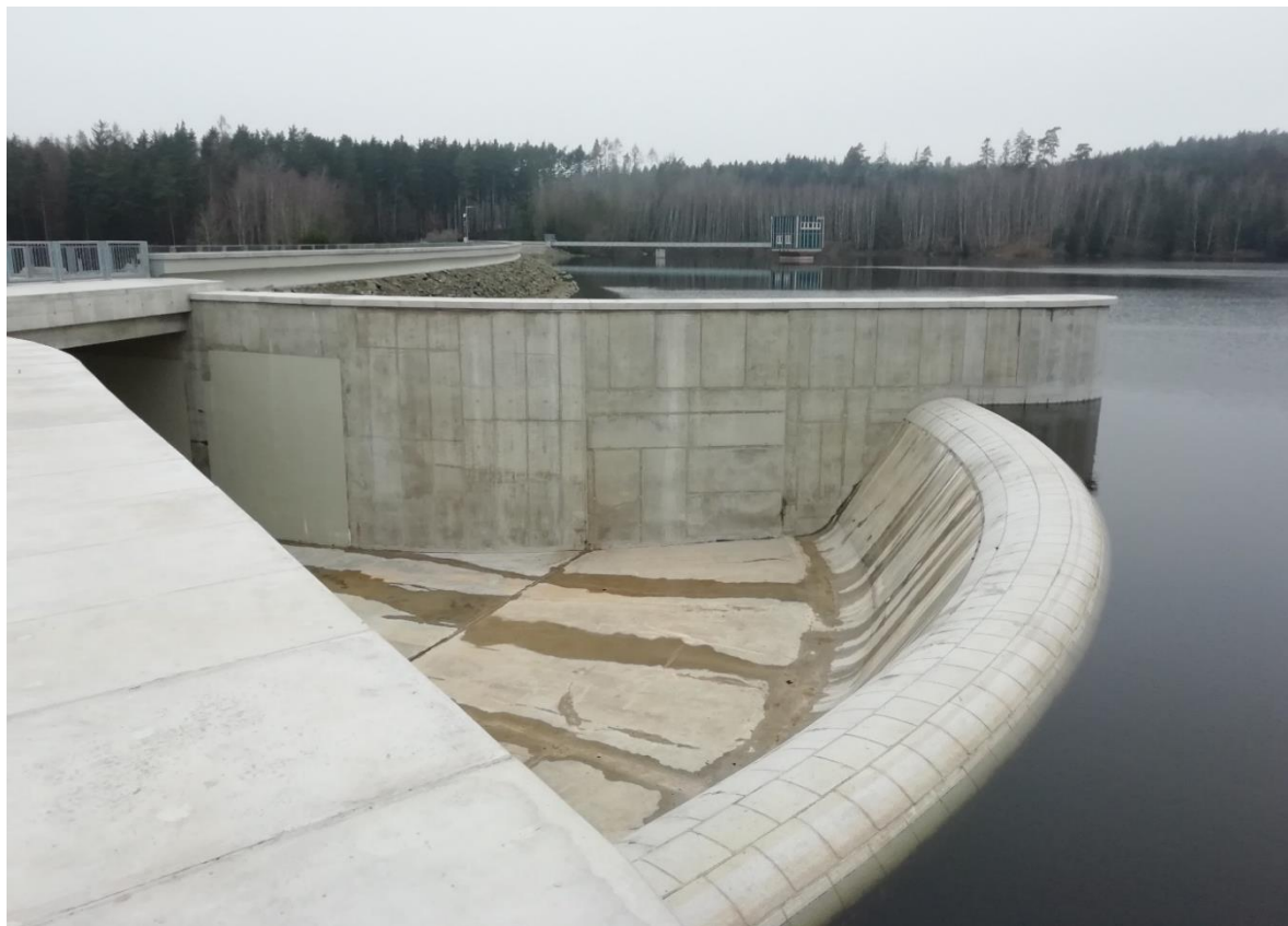
Obrázek 18: Kašnový čelní bezpečnostní přeliv [24]
