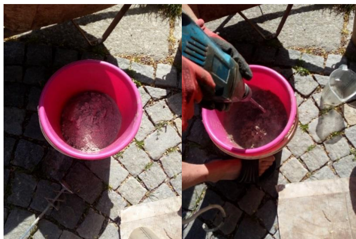
Obr. 32 Příprava cemento hliněné kaše
