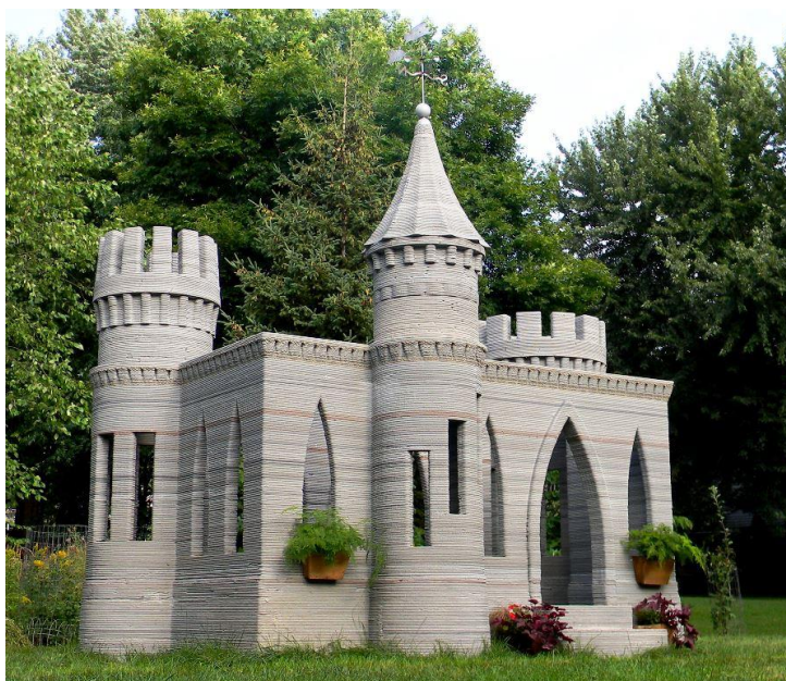
Obr. 25 První hrad v Minnesotě vytisknutý 3D tiskárnou [18]
