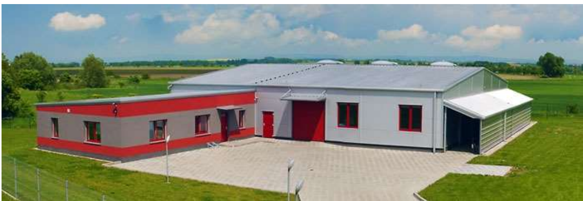
Obrázek č. 2: Sídlo společnosti PCH výroba a projekty s.r.o.
