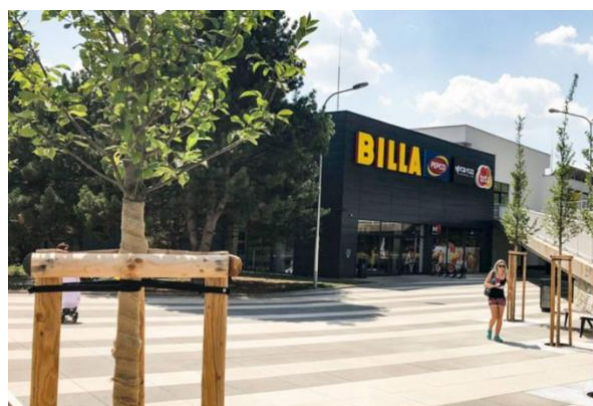
Obrázek 10-5 Severní pohled na obchodní centrum (zdroj, zpracování: vlastní)
