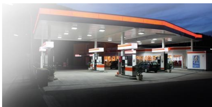
Obr. 1.2 Osvětlení čerpací stanice [4].
