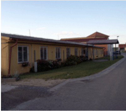
Obrázek 1: Výrobní hala Tvrdonice
