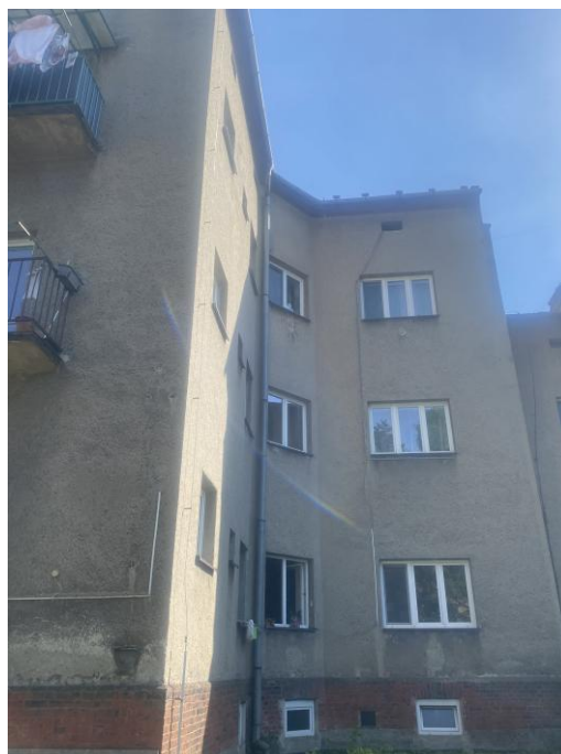
Obrázek 6 Posuzovaný objekt - severní pohled
