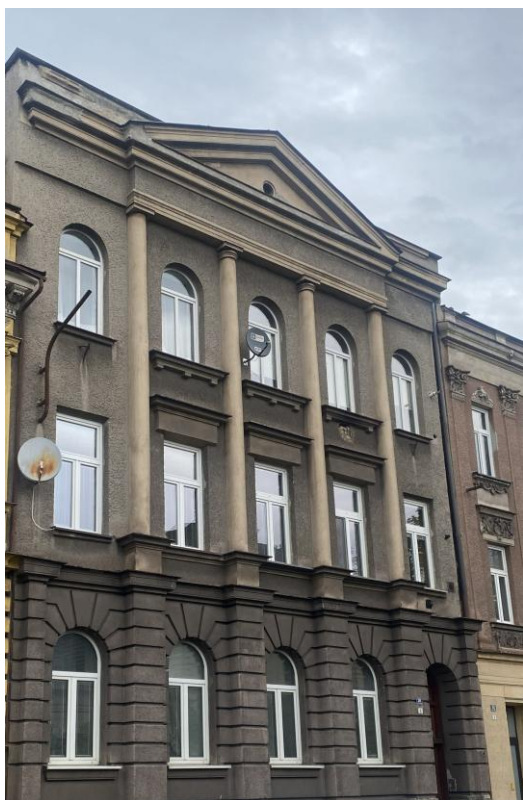
Obrázek 5 Posuzovaný objekt - jižní pohled
